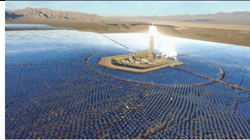
Planta Ivanpah en el desierto de Mojave (California), USA.
